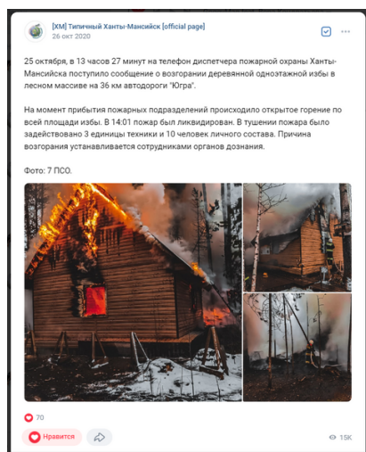
Пожар, сгорел дом Егеря 25.10.2020 г. Причиной возгорания стала вышедшая по сроку службы печка.
